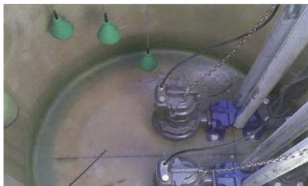
Gestión de alternancia de bombas, umbrales de arranque/paro según tarifas horarias y control de señales de fallo, inhibición de bomba y boya de nivel bajo/alto.
